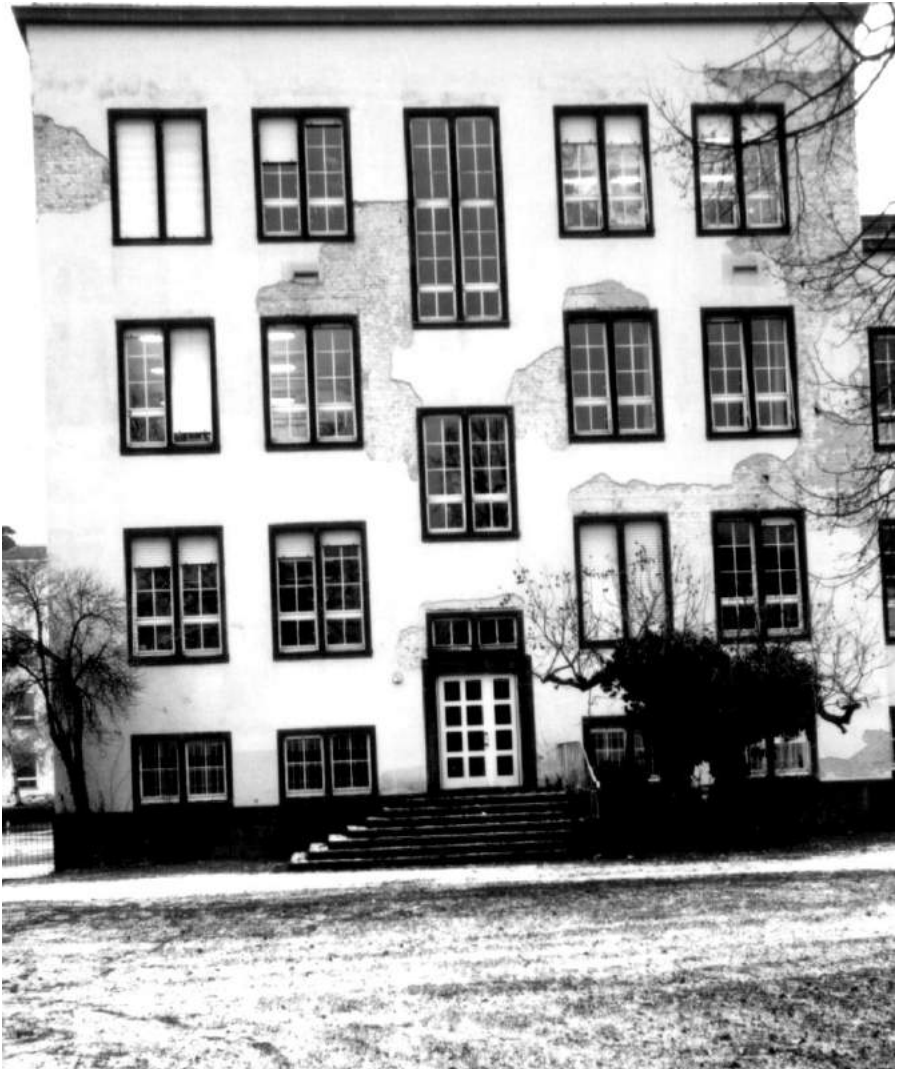
E-Trakt des Eduard-Zintl-Instituts. Die Fassade dieses Trakts war noch relativ gut erhalten.
