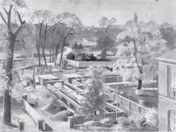
Zeichnung der Bauarbeiten am Fundament des Zintl-Instituts um 1930.
